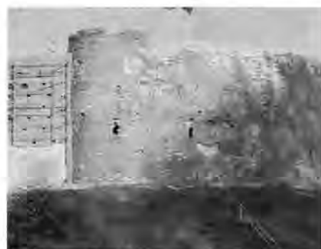
Zewnętrzne lico muru obwodowego i wieży (część południowa, stan przed wykonaniem prac remontowo-konserwatorskich) Fot. Łukasz Bednaruk
