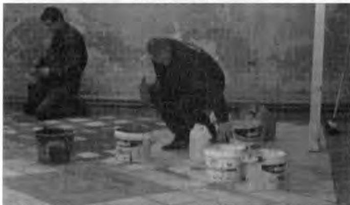
W ramach szkolenia kursanci wyremontowali świetlicę szkolną i toalety
