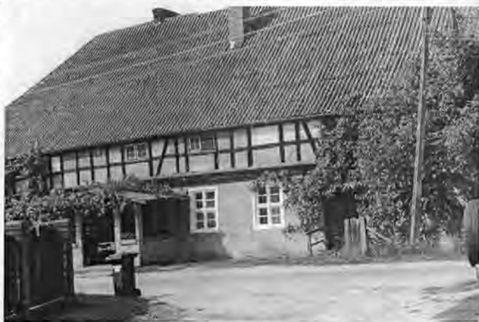
Budynek młyna wodnego w Kuźniku - stan z 2002r.
