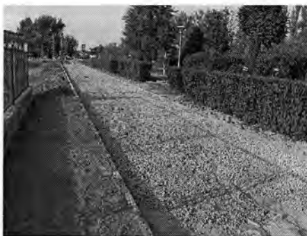
remont chodnika przy ul. Waszkiewicza 57.
