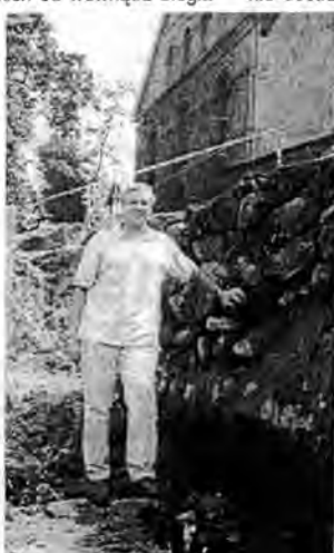
Fragment fundamentów murów przy ul. Ogrodowej
