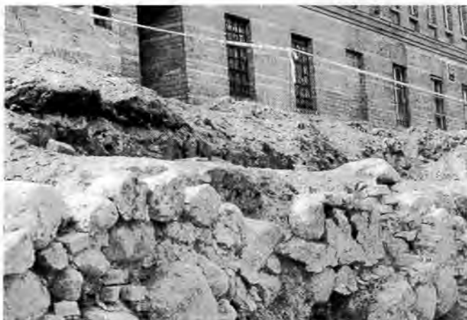
Fragment muru obronnego przy ulicy Ogrodowej
