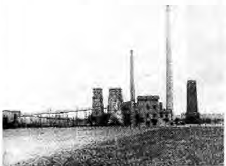
Ogólny widok byłej elektrowni Kęszycza
