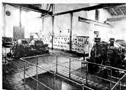
Agregaty prądowocze - elektrownia Kęszycza
