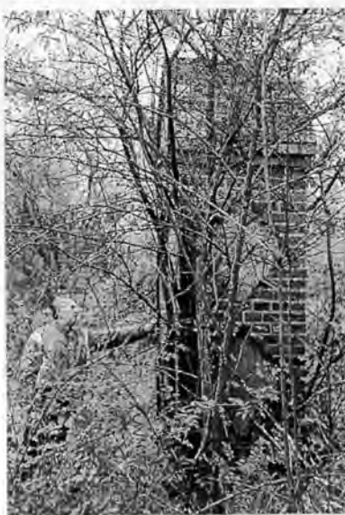
Pozostałości bramy wjazdowej na teren elektrowni. Autor przy słupie bramnym
