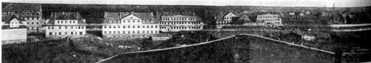
Budowa domów przy ul. Hindenburga - Kilińskiego 1925r.
