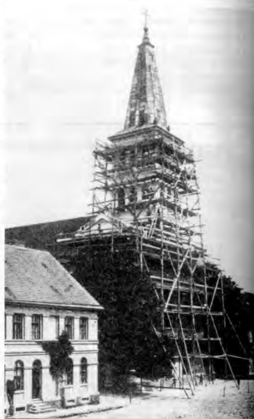
Remont kościoła w Rynku przez firmę budowlaną P. Donatha. 1925r.
