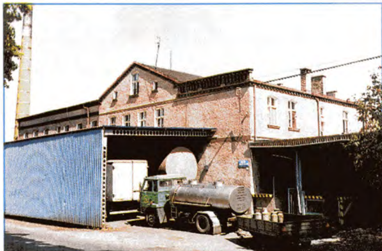
Zakład po modernizacji..
