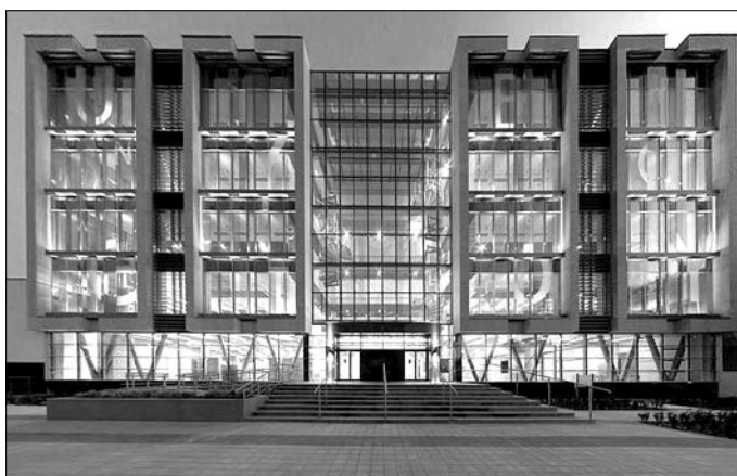
Fot. 1. Front Biblioteki Głównej
