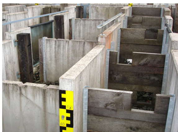
Fig. 1. Baffle fishway in Schleusingen/Gernany (photo Tymiński)
