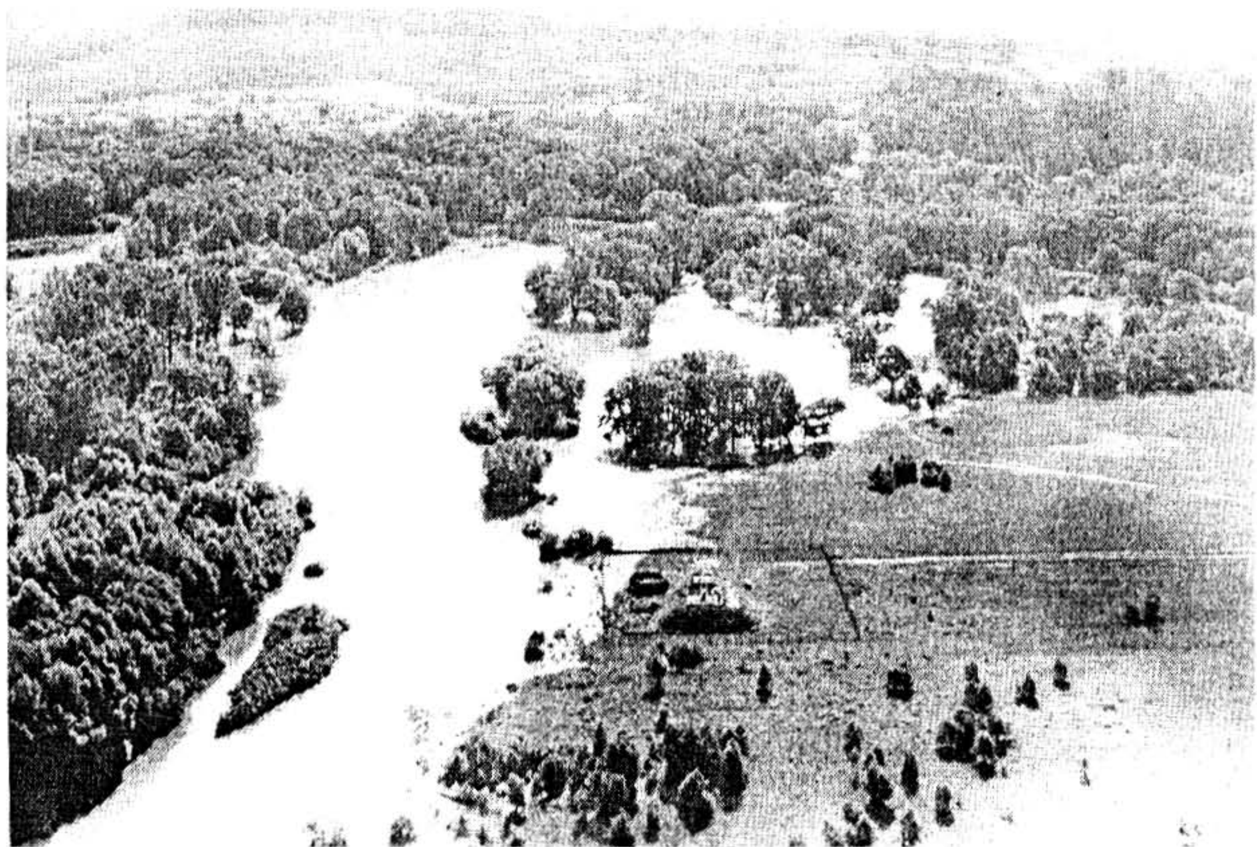
Nowogród Bobrzański – podtopiona oczyszczalnia ścieków na lewym brzegu rzeki (28 lipiec 1997), fot. aut.
